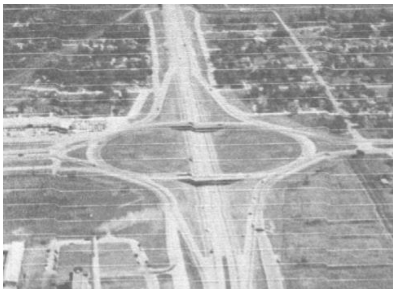
Figura 2.5 - Interconexão do tipo Giratório
